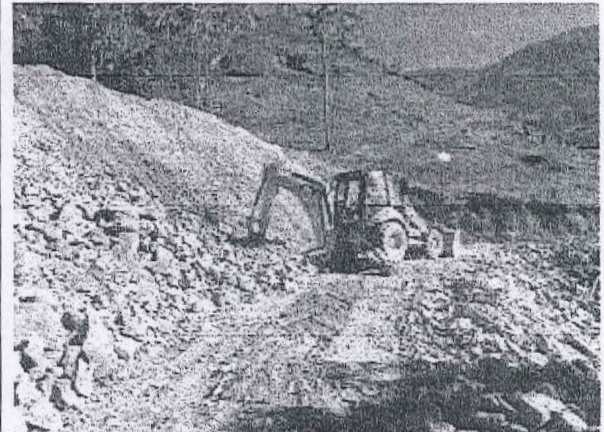
Prog: 3+005; Coordenadas: E: 730163.00; Fecha: 31/12/2020 N:9183566.00
