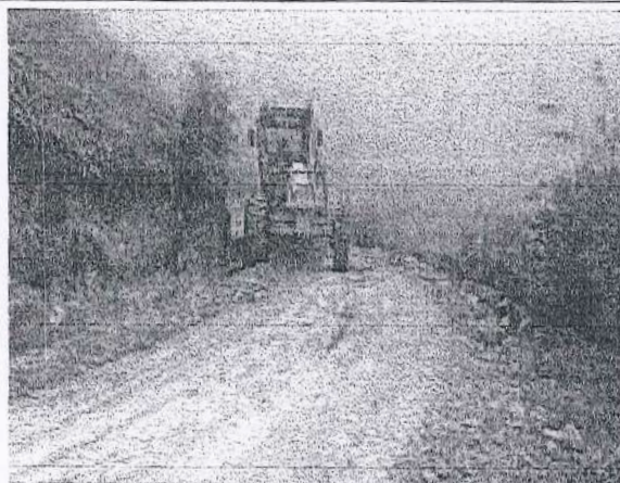
Prog: 3+750; Coordenadas: E: 729778.00; Fecha: 31/12/2020 N:9183422.00
