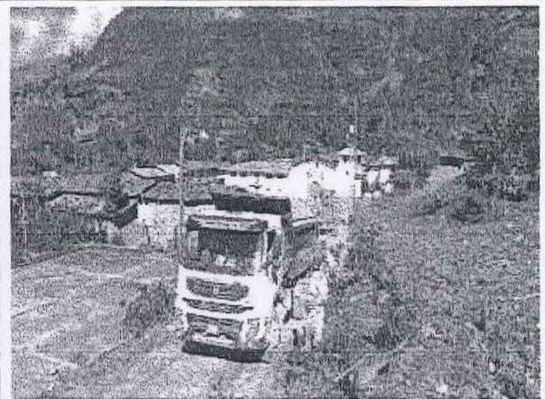
Prog: 3+750; Coordenadas: E: 729778.00; Fecha: 31/12/2020 N:9183422.00
