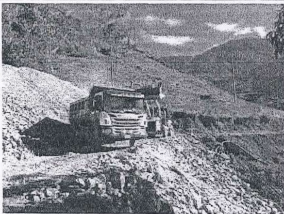
Prog: 3+005; Coordenadas: E: 730163.00; Fecha: 31/12/2020 N:9183566.00
