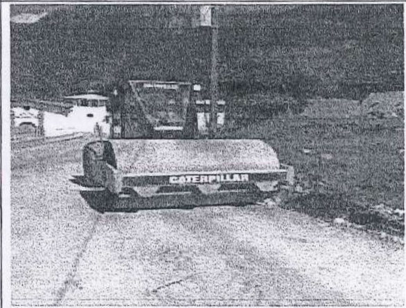
Prog: 3+750; Coordenadas: E: 729778.00; Fecha: 31/12/2020 N:9183422.00
